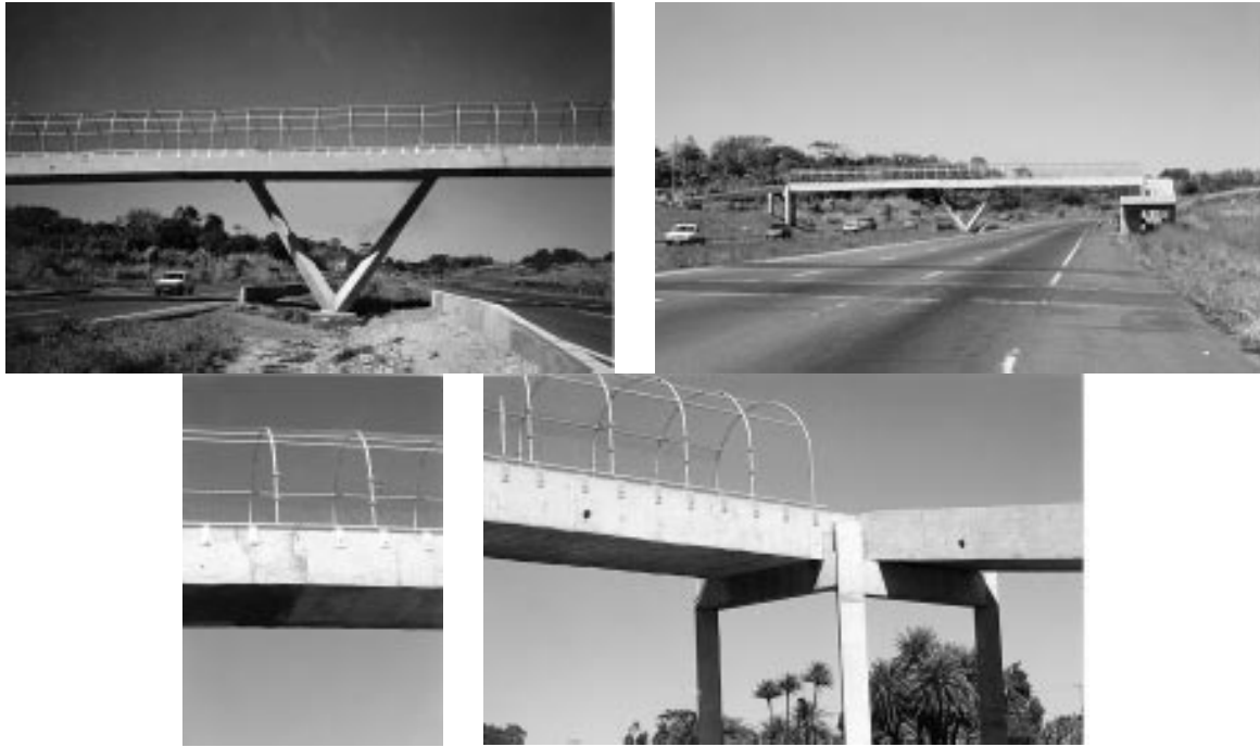
Figura 1: Passarela de pedestres: a) e b) vista geral; c) detalhe da rótula; d) apoio na rampa.
