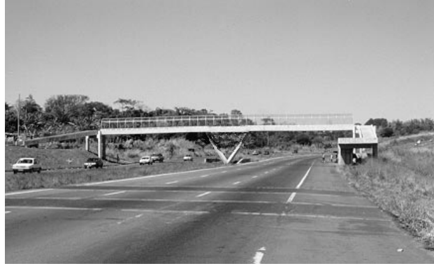
Figura 1.6: Passarela de pedestres.
