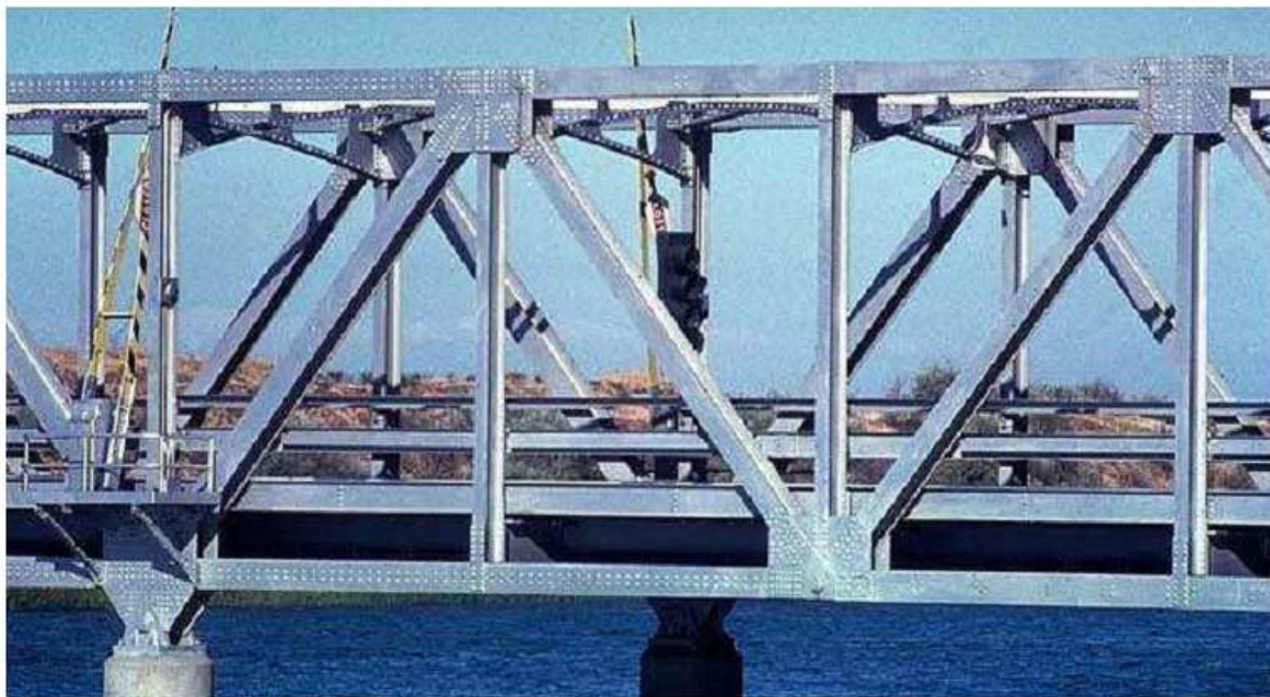
Ponte levadiça, delta do rio Sacramento, próximo de Rio Vista, California, EUA.
