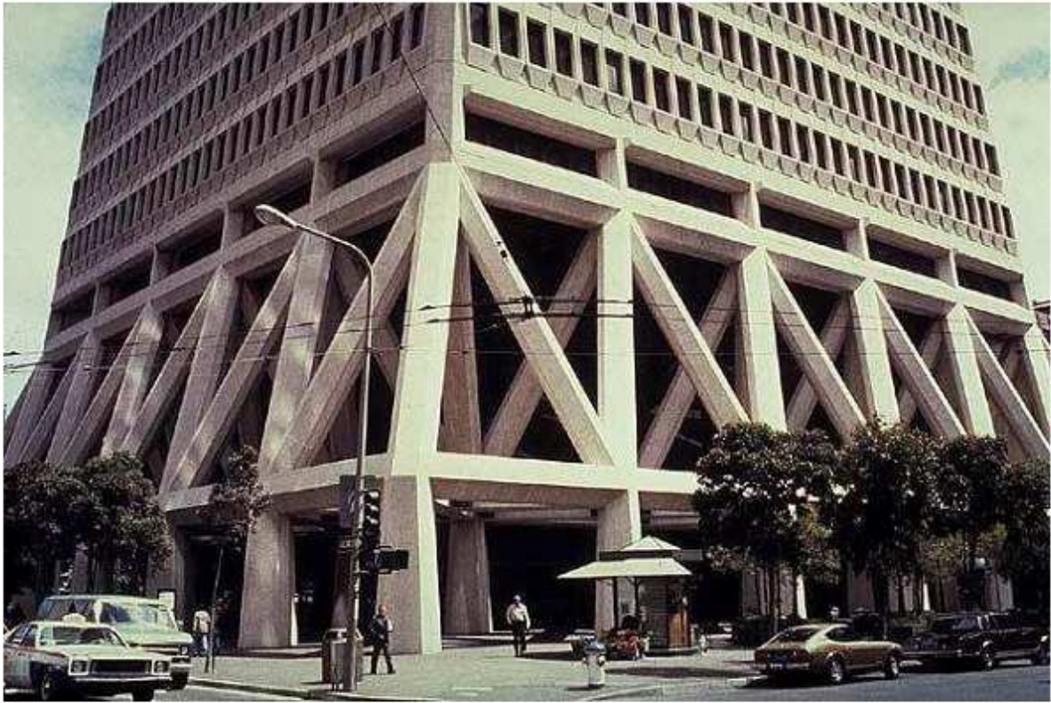
Base do edifício Transamerica, San Francisco, California, EUA.
