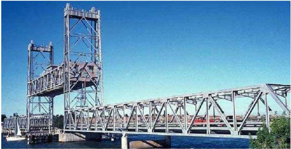
Ponte levadiça, delta do rio Sacramento, próximo de Rio Vista, California, EUA.
